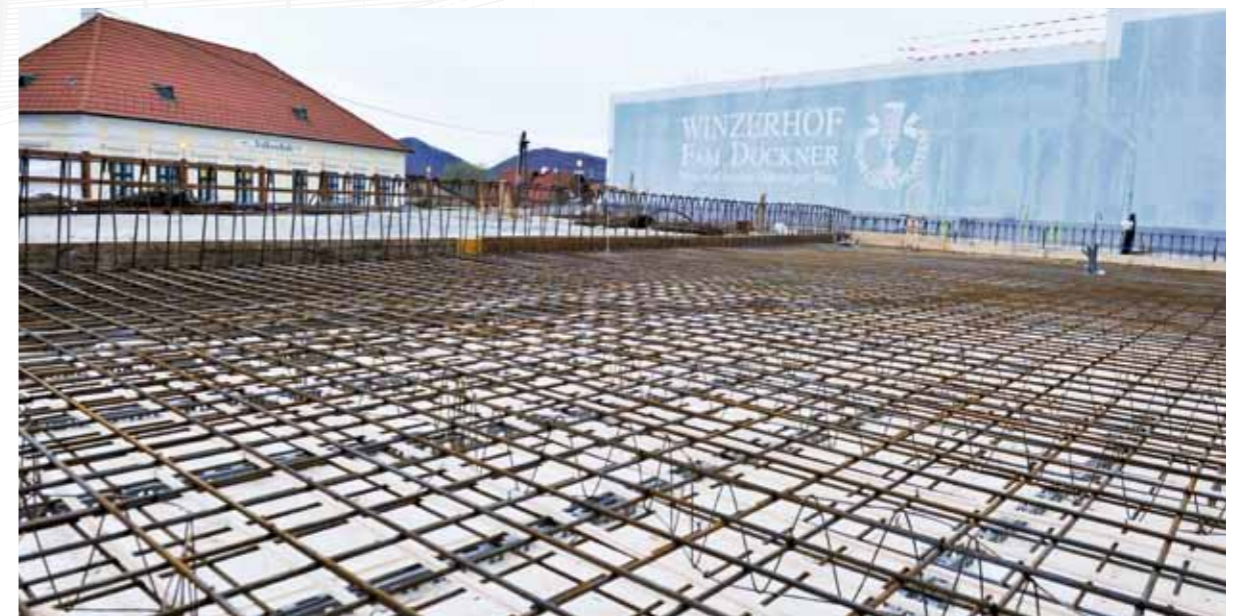
Vorbereitungsarbeiten für die Fundamentplatte
